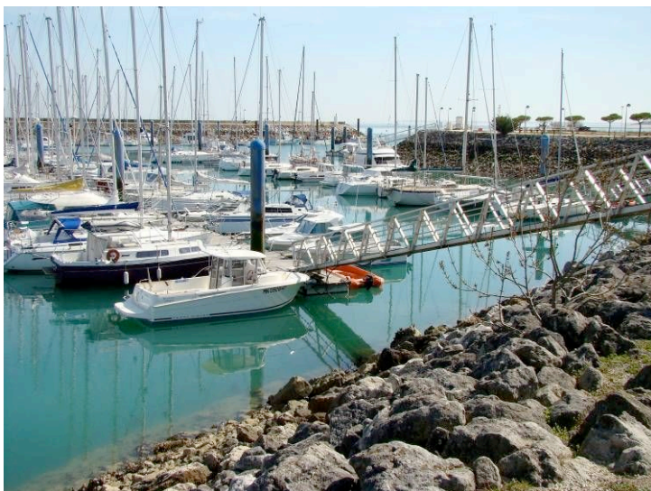
Fig. 2 – Le port de Saint-Denis après la tempête : aucune dégradation ne s’observe, le bassin étant efficacement protégé par les digues et jetées massives qui l’encadrent.
