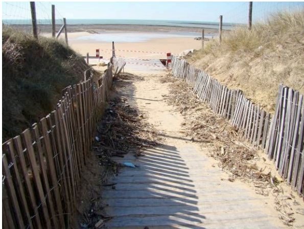
Fig. 27 – Caillebotis menant à la rampe d'accès à la plage. L'on peut noter que les vagues de tempête ont projeté du sable et des végétaux sur le sentier d'accès à la plage.
