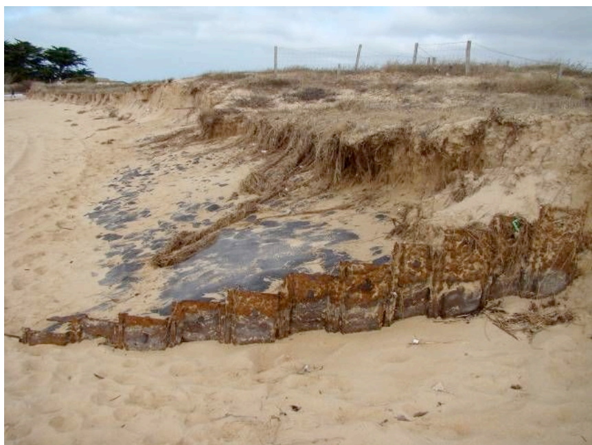
Fig. 26 – Ouvrage en goudron et métal mis à nu par le recul de la dune au nord du centre nautique de la baie de la Perroche.
