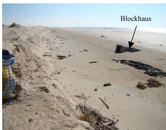
Fig. 37 – La position du même blockhaus après la tempête Xynthia témoigne d'une recul de la dune de plus de 20 mètres.
