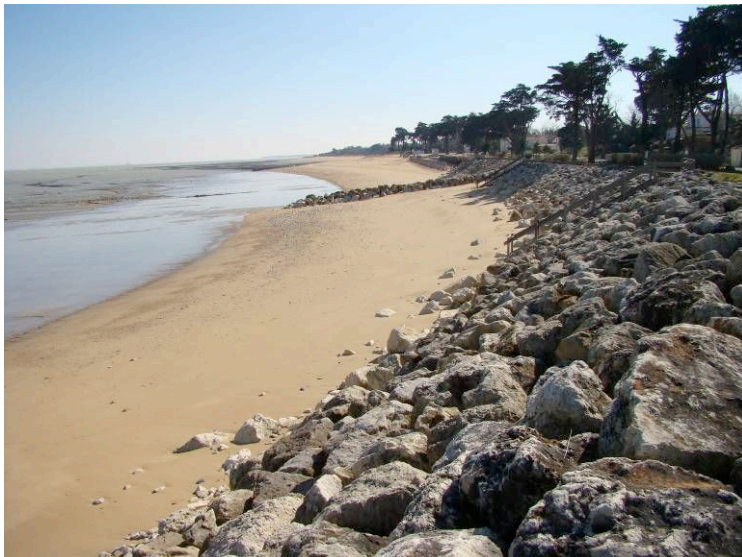
Fig. 7 – Plage de Planginot, la Brée-les-Bains La plage s'est maintenue. Le cordon d'enrochement n'a pas été déstabilisé.
