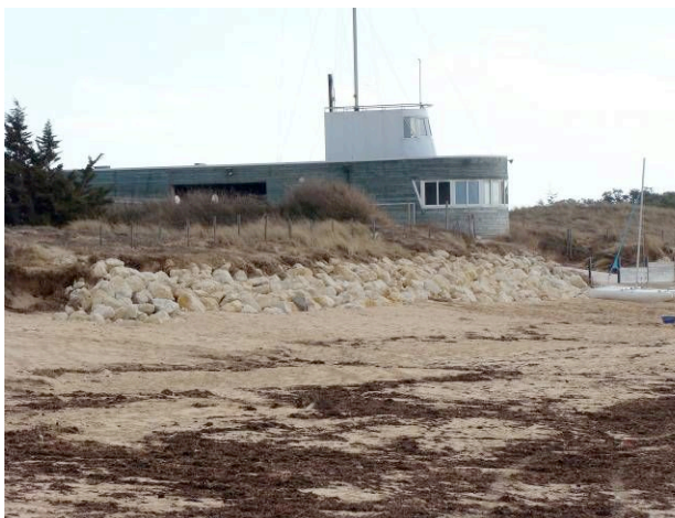
Fig. 24 – Stabilité du secteur central en raison de la présence d'un cordon d'énrochement massif.
