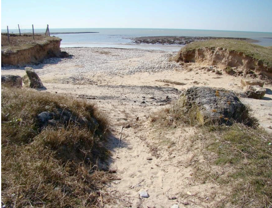
Fig. 13 – Vue sur la brèche ouverte dans la dune, qui a permis aux vagues de s'engouffrer et de détruire la route côtière goudronnée.
