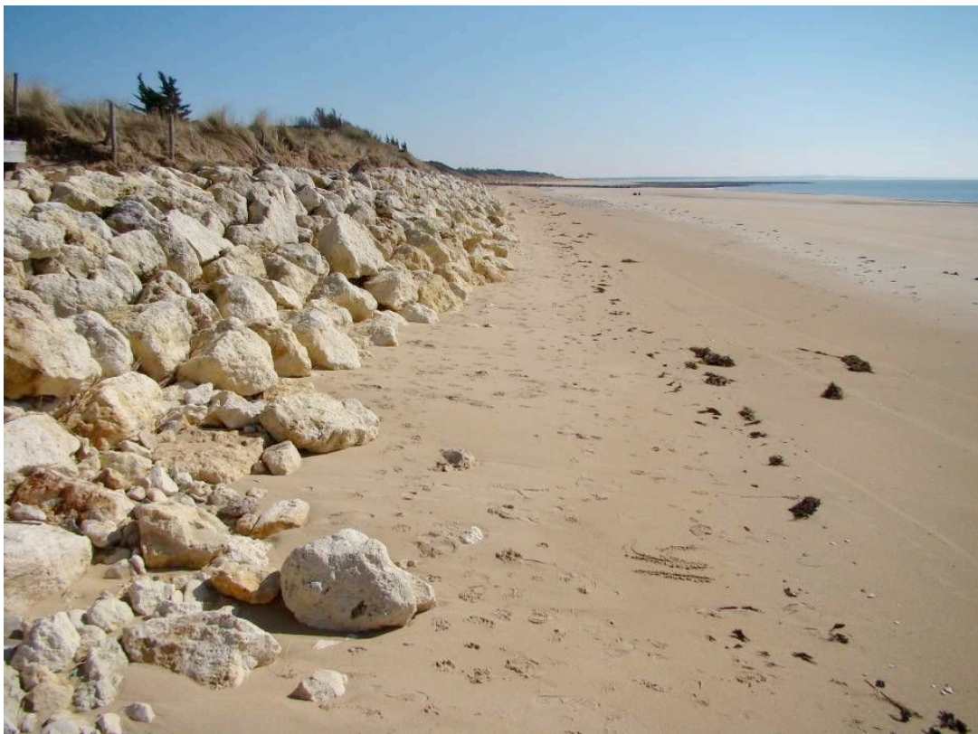
Fig. 29 – Vue vers le sud de la plage de la Rémigeasse après la tempête. Le cordon d'enrochement a protégé la dune dans la partie centrale de la plage.
