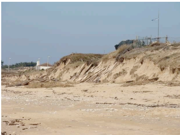
Fig. 18 – Érosion de la dune aux Huttes, au nord de l'accès principal, et installation de pieux sur la falaise par les résidents pour freiner l'érosion.
