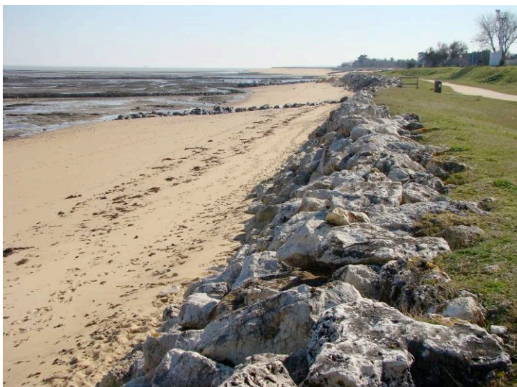
Fig. 4 – Le cordon d’enrochement qui borde la plage entre la Boierie et la pointe de Proires. L’on peut observer le bon état sédimentaire de cette plage, tout à fait comparable à celui d’avant la tempête.
