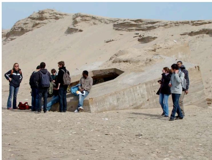
Fig. 41 – État de la falaise taillée dans la dune à La Giraudière trois semaines après la tempête Xynthia. Cette falaise présente une pente nettement moins raide qu'au début du mois de mars. Son profil se régularise progressivement.
