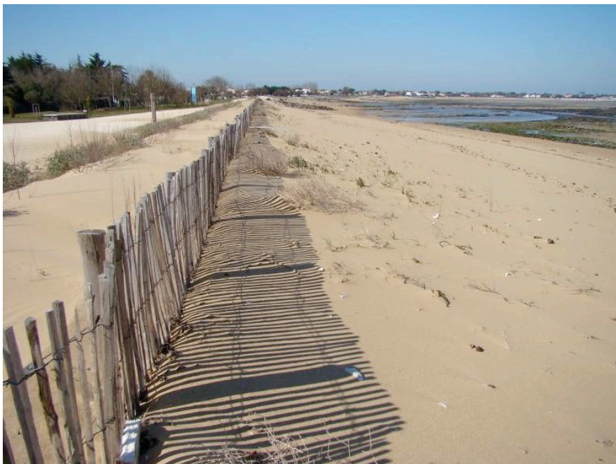
Fig. 5 – La plage artificielle adossée à la digue de la pointe de Proires (vue vers le nord) : maintien de l’état sédimentaire de la plage, de la végétation du haut de plage et absence de dégradation des ganivelles. L’estran qui découvre à marée basse avait conservé sa nature rocheuse après le passage de Xynthia, en l’absence de transfert de sédiments significatif vers le bas de plage et les petits fonds marins.
