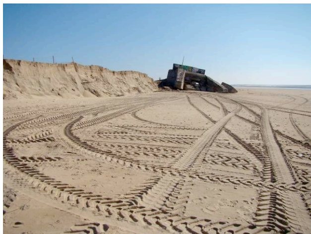
Fig. 34 – Basculement des blockhaus sur la plage à la suite du passage de la tempête Xynthia .
