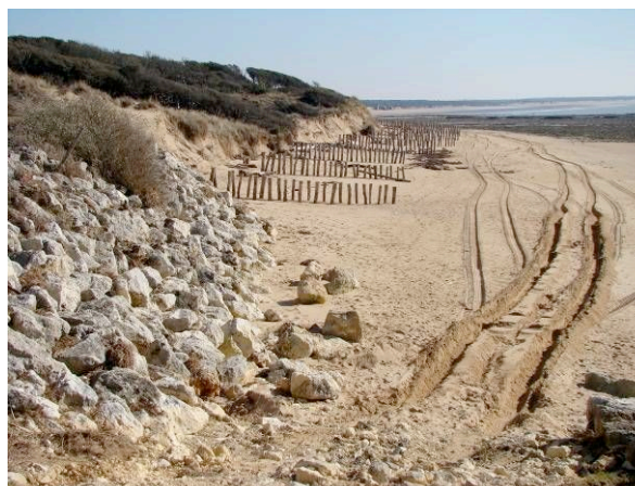
Fig. 31 – Vue vers le sud, secteur de l'Écuissière. Le recul de la dune boisée a été de l'ordre de 1 à 3 m.
