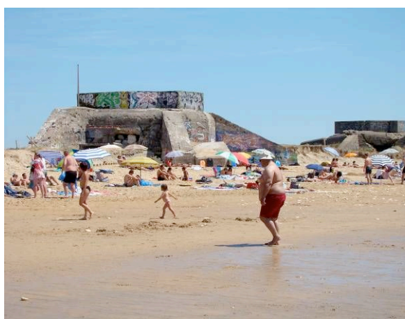
Fig. 33 – Position de ce même blockhaus à cheval entre la dune et la plage le 26 juillet 2009.
