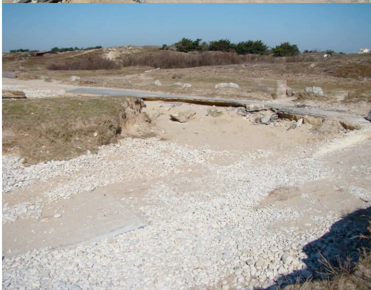
Fig. 16 – Destruction de la route côtière dans l'axe de la brèche ouverte dans la dune
